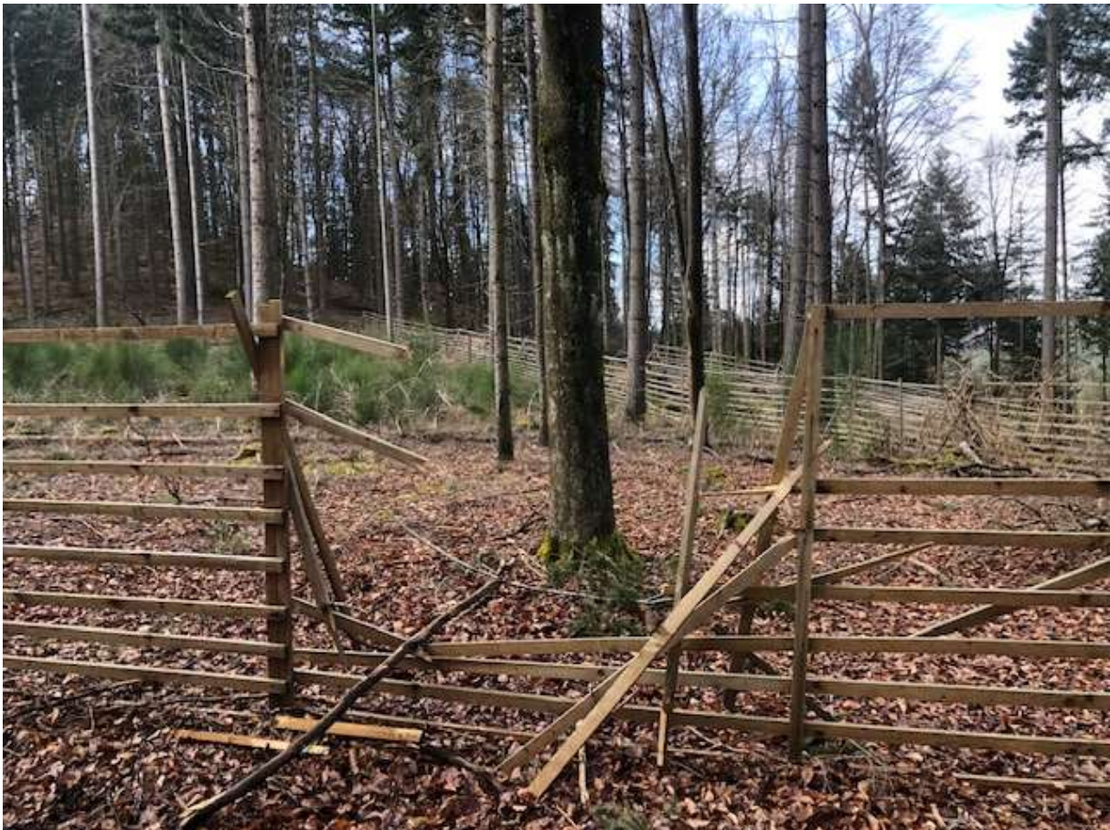
Abbildung 6: Zaunkontrolle und Reparatur
