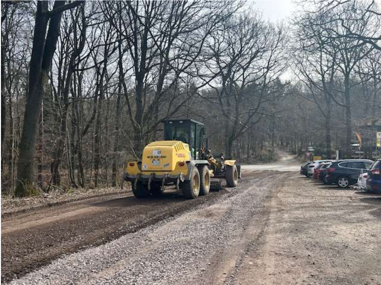
Abbildung 5: Grader beim Materialeinbau auf der Lindemannsruhe
